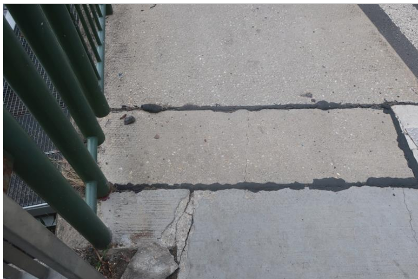
trhliny v levém chodníku u MZ O1
