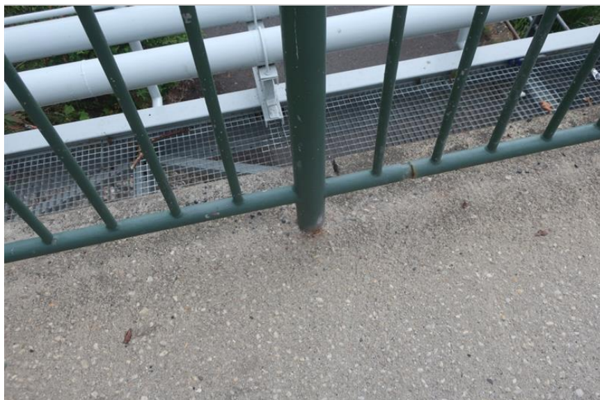
počínající koroze zábradlí
