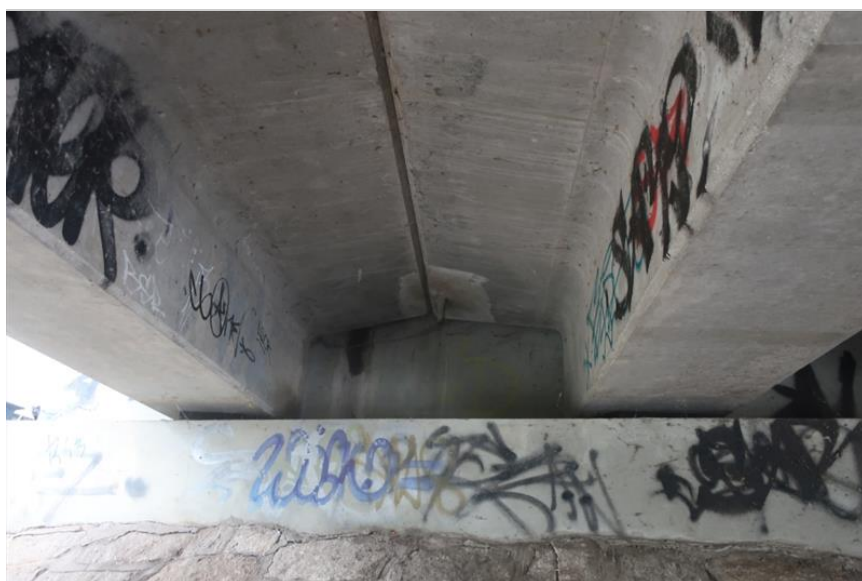
aktivní průsak dilatační sparou nad opěrou O1
