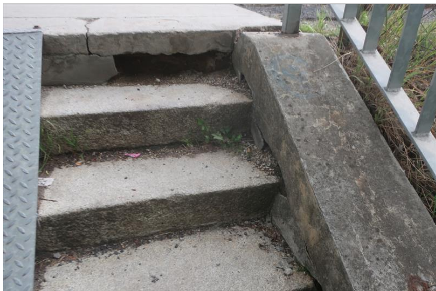
rozpad části pravého schodiště O4
