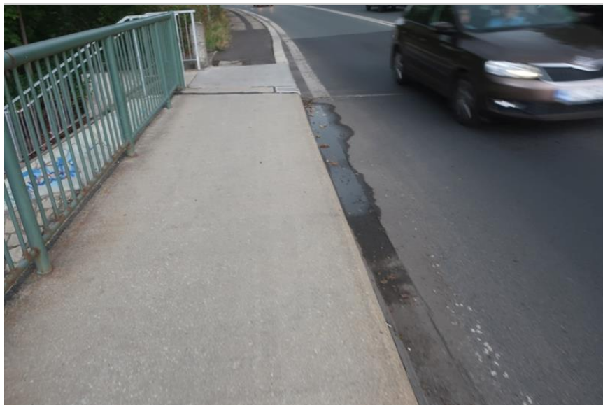
v 1. poli dochází v pravém odvodňovacím proužku k zadržení vody
