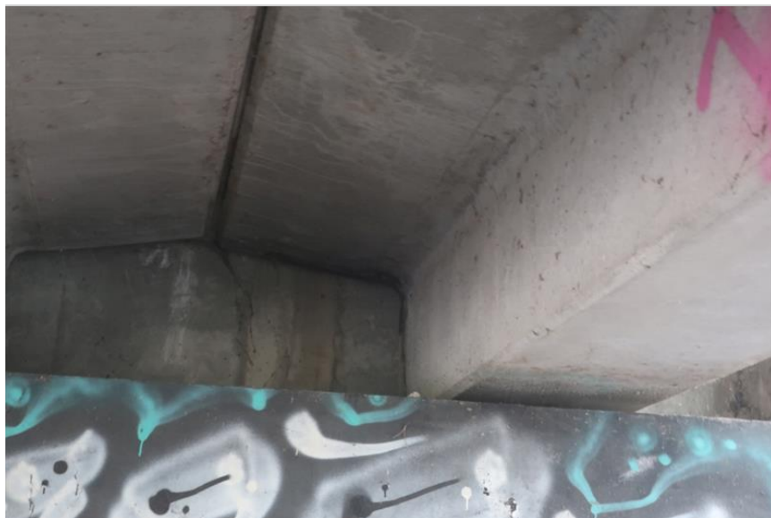
stopy po průsacích na líci závěrné zídky O4
