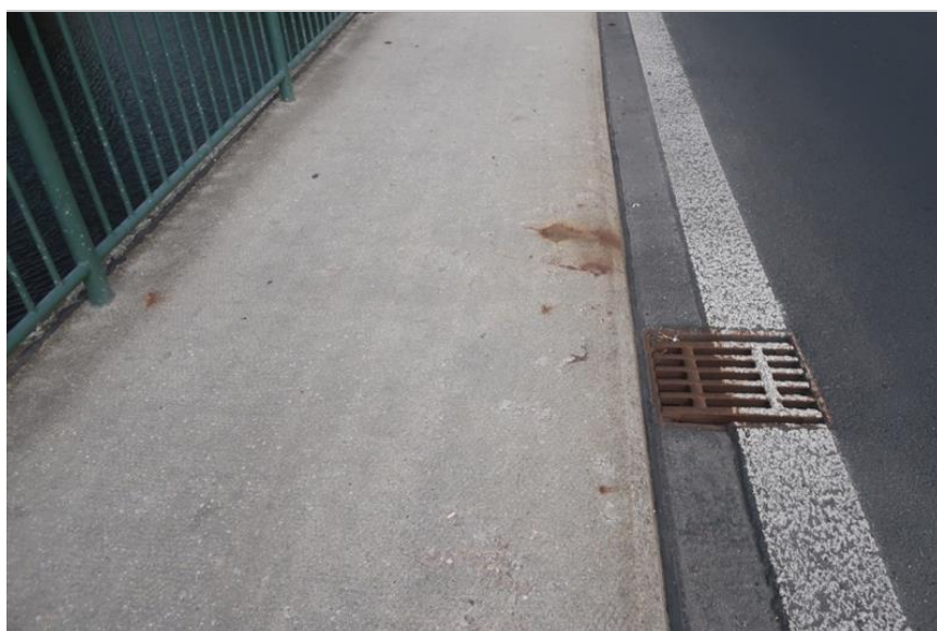
stopy koroze na lici pravého chodníku
