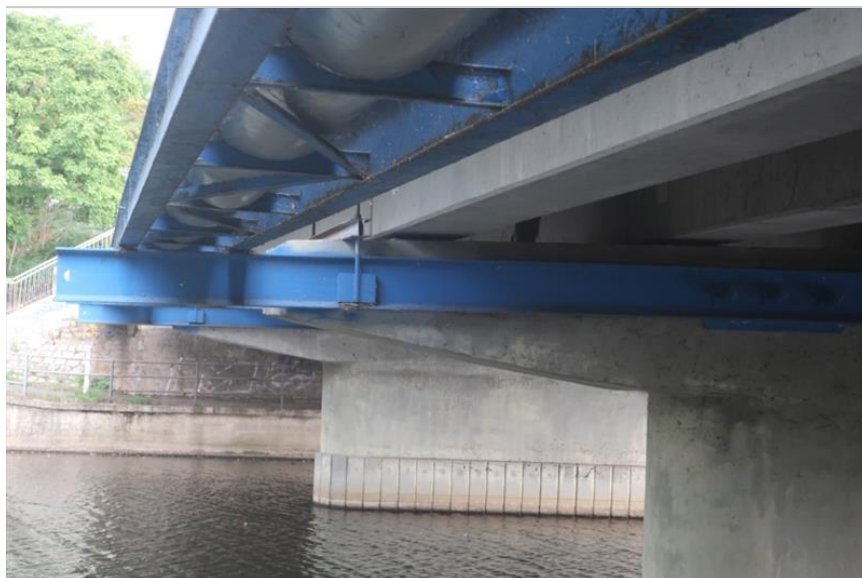
podhled pravé technologické lávky
