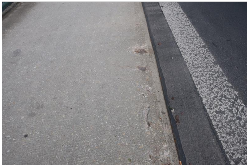
separace krycí vrstvy nad korodující výztuží na horním lici pravého chodníku
