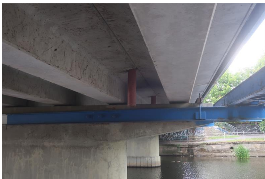
detail uložené technologické lávky na stativu pilíře P2
