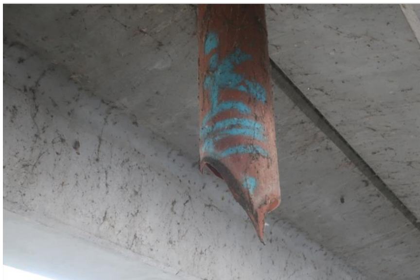
poškozený svod dodvodiňovače
